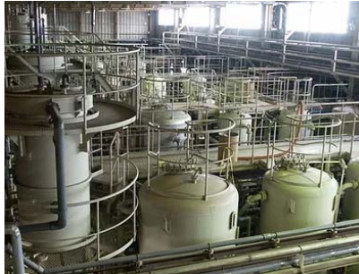
電気計装工事 (工場、プラント内他)
