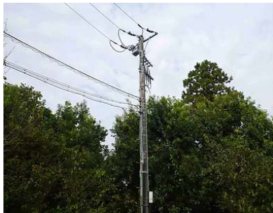
PAS、高圧ケーブル施工
