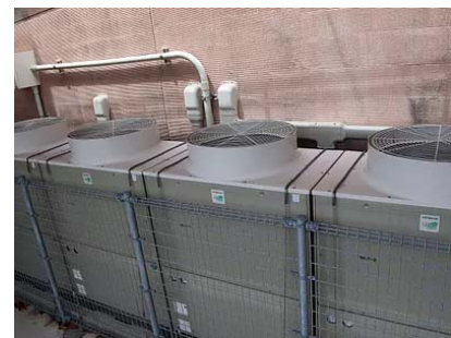
工場空調施工、更新
